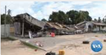
Beim bewaffneten Konflikt zerstörtes Gebäude in der Provinz Cabo Delgado
